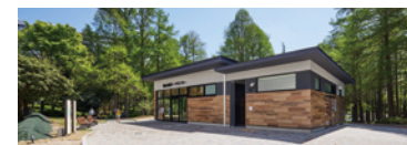
桃山公園（新設したパークセンター）
